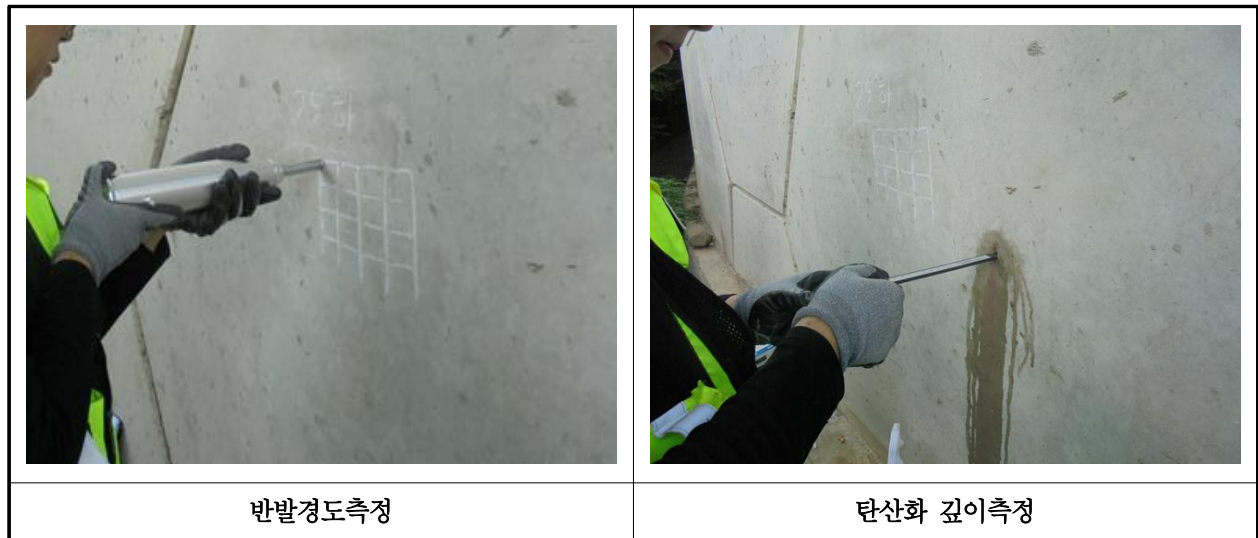
【사진 14.4.1】 재료시험 조사 전경
