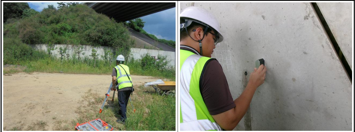
【사진 14.4.2】 측량작업 전경
