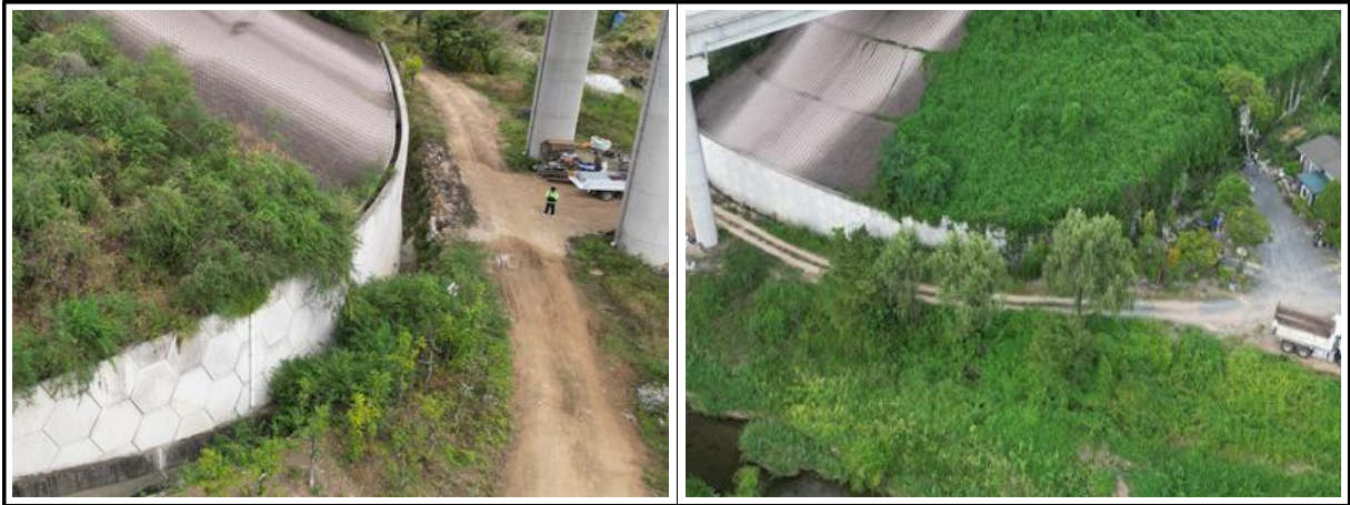
【사진 14.3.1】 지반, 기초부 전경
