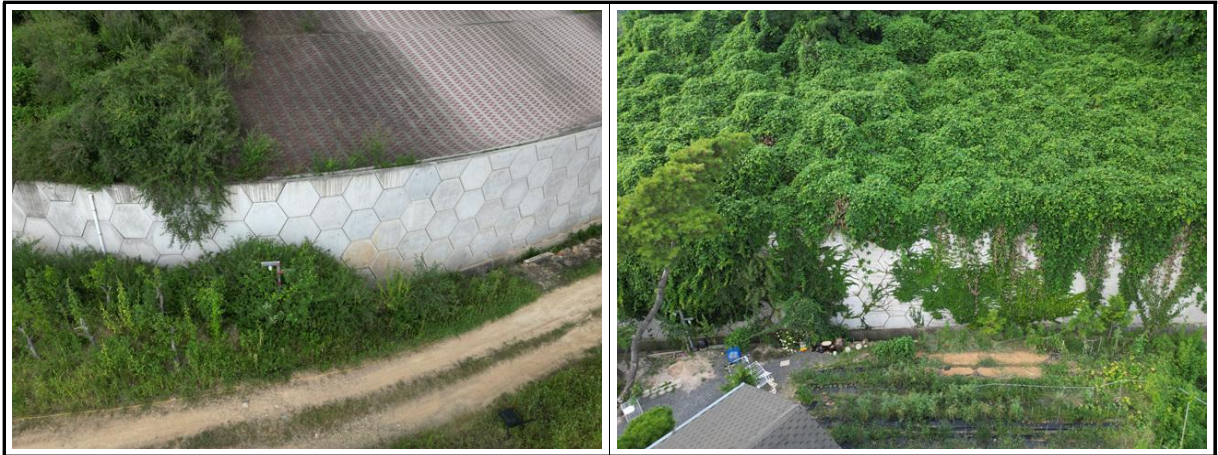
【사진 14.3.2】 전면부 전경
